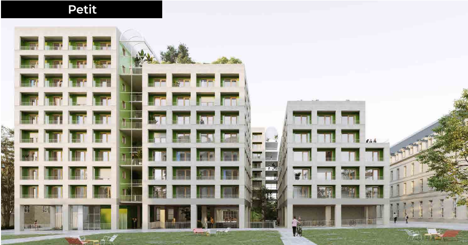
Bâtiment Petit -Vue depuis la croisée centrale de la ZAC © Jeudi Wang
