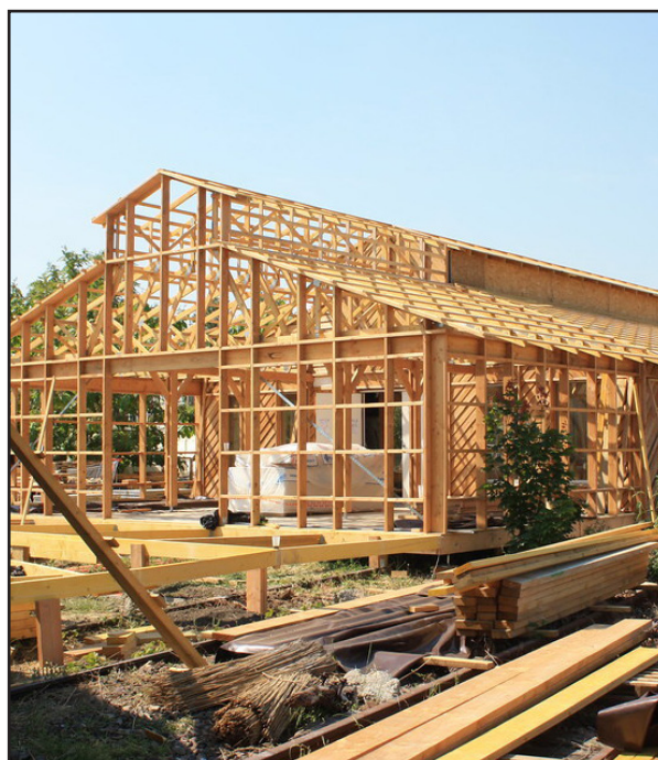
2. Photographie bâtiment en construction
